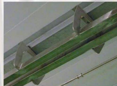
La red es de tipo **DOBLE VÍA**, formada por 2 perfiles 50x40x2 ó 60x40x2 de acero inoxidable AISI 304, separados 18-20mm.
